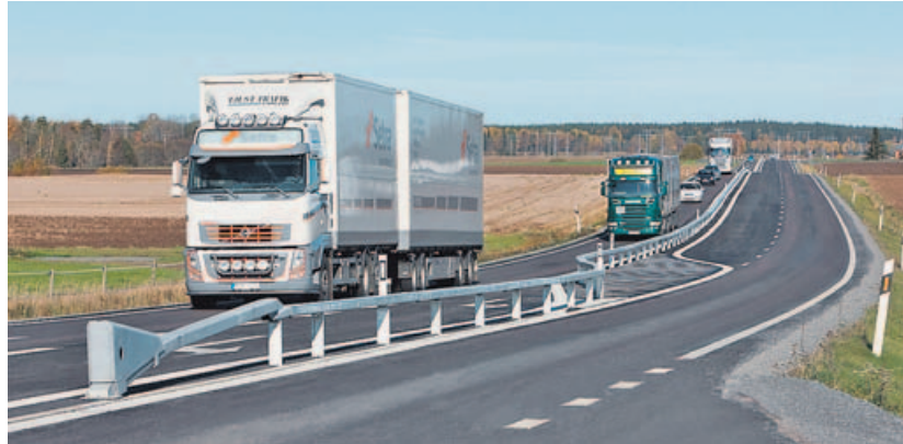
El primer 2+1 de España, en Cataluña. Imagen del inicio de uno de los tramos 2+1 aplicado en la carretera C-55, con carriles separados por biondas que permiten el adelantamiento seguro. FERRÁN CAMPS
